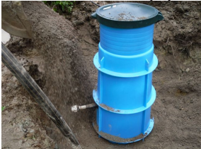
Täyttö soralla, kerroksittain tärytys
