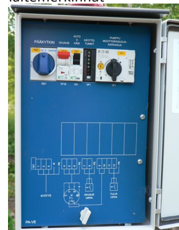
Sähköohjauskeskuksen laitemerkinnät
