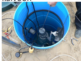
Pumpun laskeminen kaivoon
